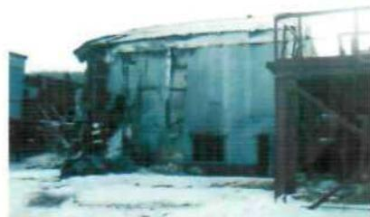
Причиной пожара явилась нарушение правил пожарной безопасности при эксплуатации тепловой пушки "СФО-25/30/40", предусмотренных инструкцией завода-изготовителя, что привело к нагреву и возгоранию легковоспламеняющихся древесных частиц и возникновению пожара. В отношении лица, допустившего пожар возбуждено дело об административном правонарушении по ч.6 ст.20.4 КоАП РФ.
